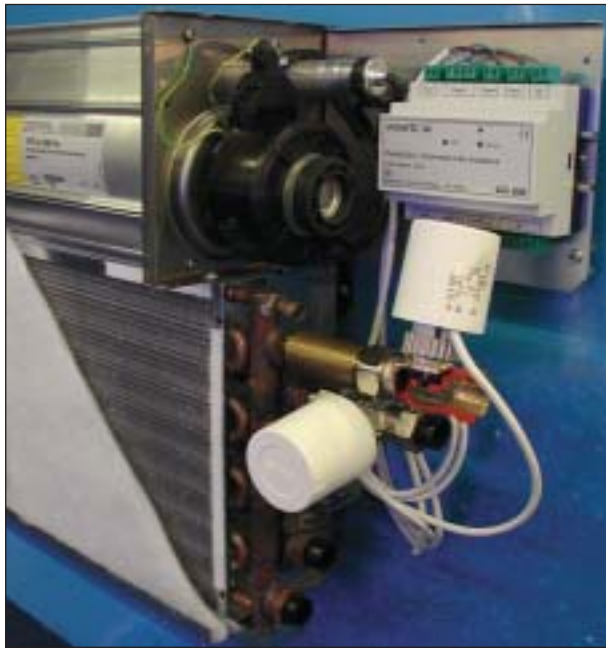
Bild 2. (BUS-House) Blick in ein Fan Coil-Gerät mit einem ecobus Regler
