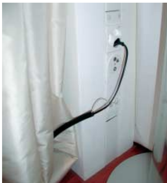
Bild 3: Anschlussstellen in den vorfabrizierten Stützen, auch für Musikanlagen, Quelle: Bus-House
