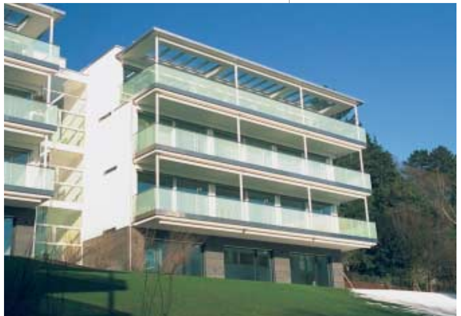
Bild 1: Blick auf den Forsterpark. Quelle: Schaeppi
