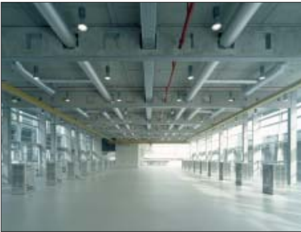
Die Produktionshallen sind frei von Stützen und Trennwänden und deshalb flexibel nutzbar. Die Architektur lässt Raum für raschen Wandel und künftige Entwicklungen. Die geschosshohen Stahlglasfassaden erlauben eine natürliche Beleuchtung und Belüftung sämtlicher Innenräume.
